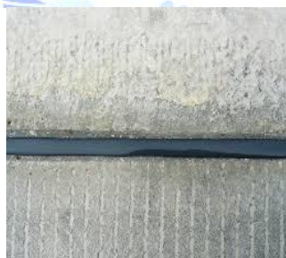
2-расм. Цементбетон қопламали чокларни герметизациясининг кўриниши
