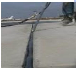
2-расм. Цементбетон қопламали чокларни герметизациясининг кўриниши
