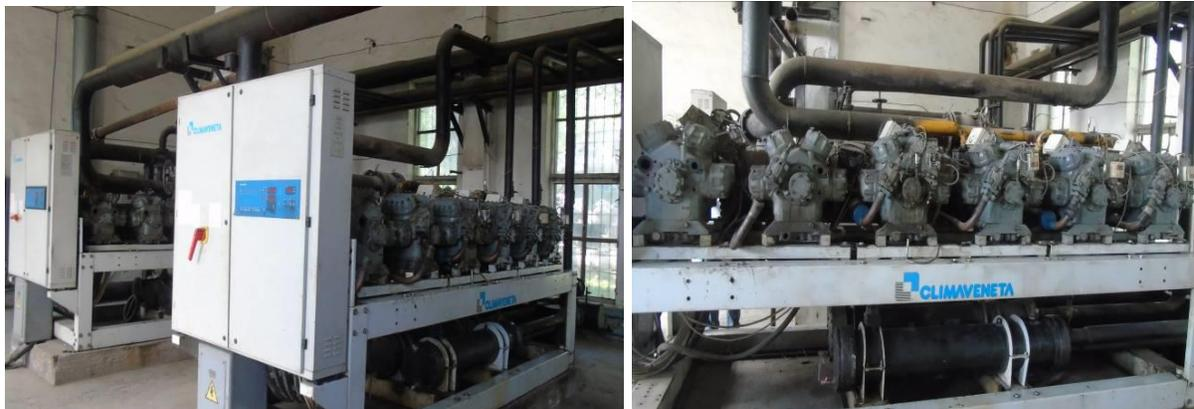
*Рисунок 1. Общий вид устаревшего чиллера, работающего на R22.*
