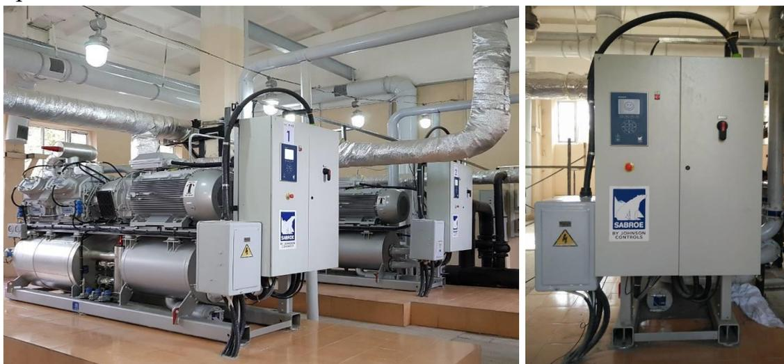
Рисунок 2. Общий вид нового чиллера, работающего на R717
