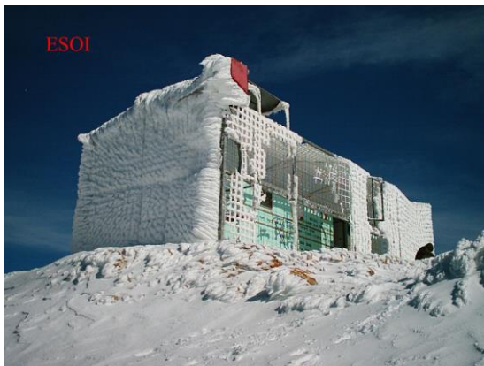
Рис.2 Накопление снега на поверхностях клетки Фарадея, которой для грозовой защиты окружена станция ESOI.
